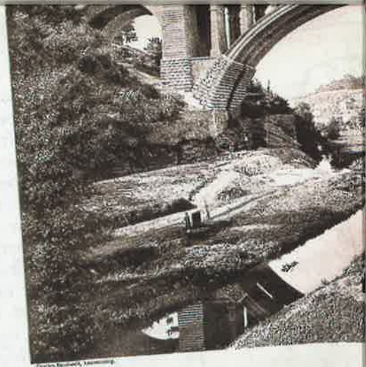
VUE DU PONT
